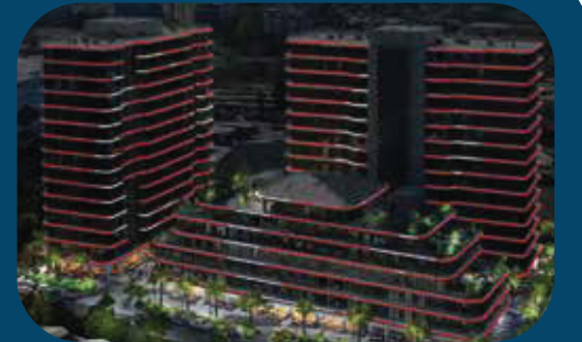
Animasyonlu Cephe Aydınlatması
